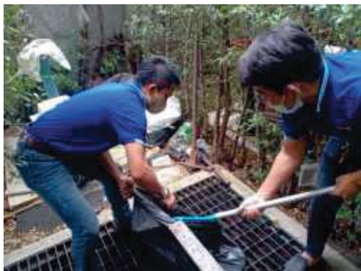
ทำความสะอาดตระแกรงดักขยะ
