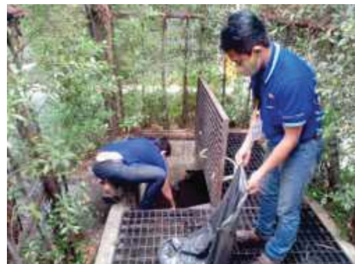
ทำความสะอาดตระแกรงดักขยะ
